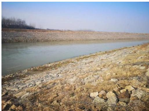
2022年5月24日，位于河南省信阳市息县的大别山革命老区引淮供水灌溉工程成功实现破堰进水。引淮供水工程护坡采用了天鼎丰聚丙烯长丝针刺土工布。其单纤强度高，整体物理力学指标高；旦数粗，孔径大，垂直渗透系数能达到0.25cm/s，等效孔径能达到0.15mm，具有良好的透水性能与抗淤堵性能；耐化学性能好，能在PH 2-13范围内稳定使用，不会因水解而消失；具有良好的抗冻融性能，能在高原冻土地区长期稳定使用，在各项水利工程中得到了广泛的应用。
